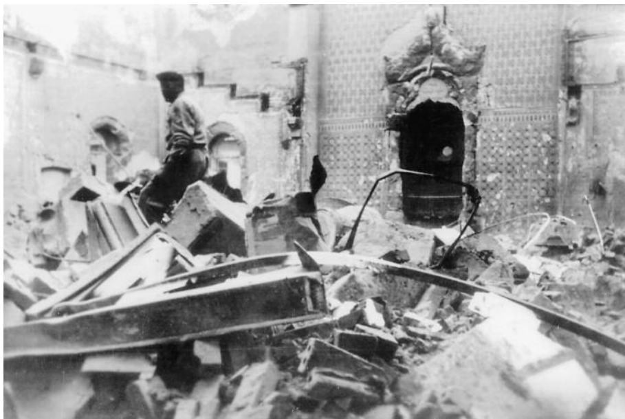
Auf dem Boden des Innenraums liegen die zerstörten Emporen, die verbrannten Ausstattungstücke und Teile des eingestürzten Dachs.
