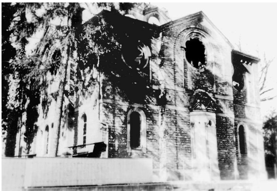
Blick auf die zerstörte Synagoge von Südosten vom Hof der benachbarten Schule.
