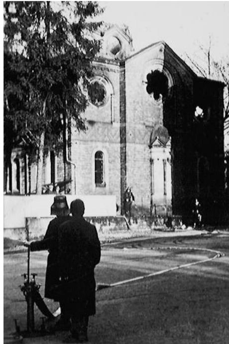
Die Feuerwehr beim Ablöschen der Brandnester und sichern der Brandruine.
