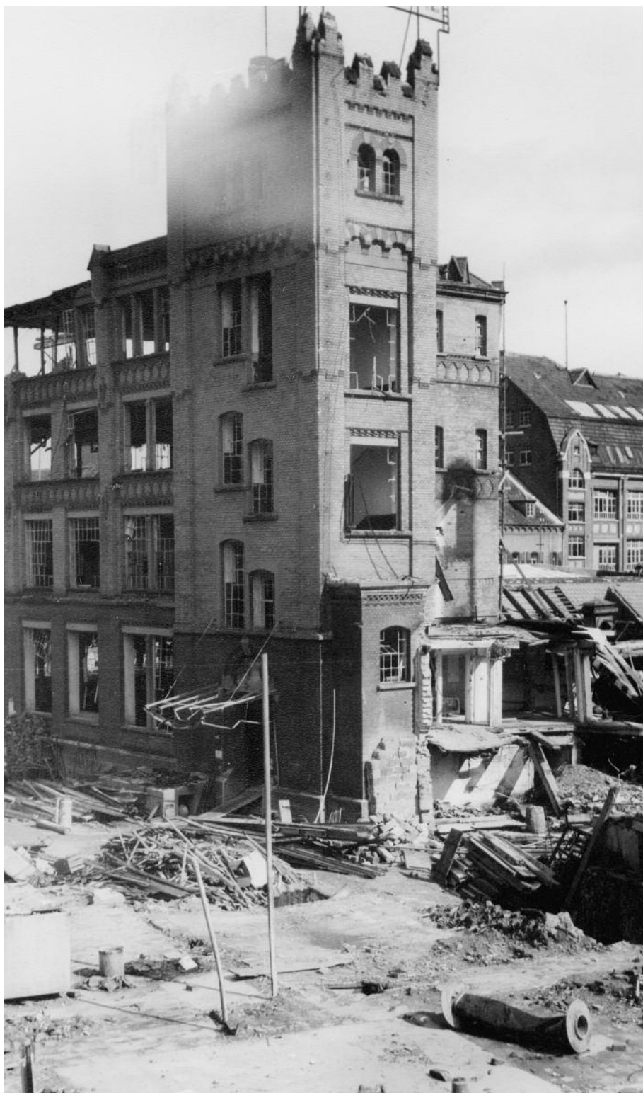
Beim Luftangriff am 12. April 1945 wurde das Fabrikgelände Gebr. Frankfurter stark beschädigt.
